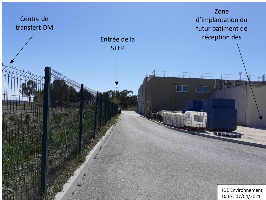
Photo 3 : Vue vers l'entrée de la STEP depuis la limite Sud-Est de la zone de méthanisation
