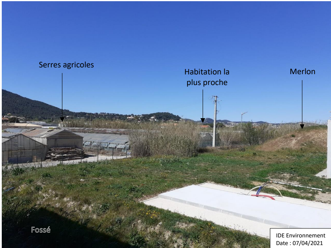
Photo 2 : Vue sur l'Ouest du site
