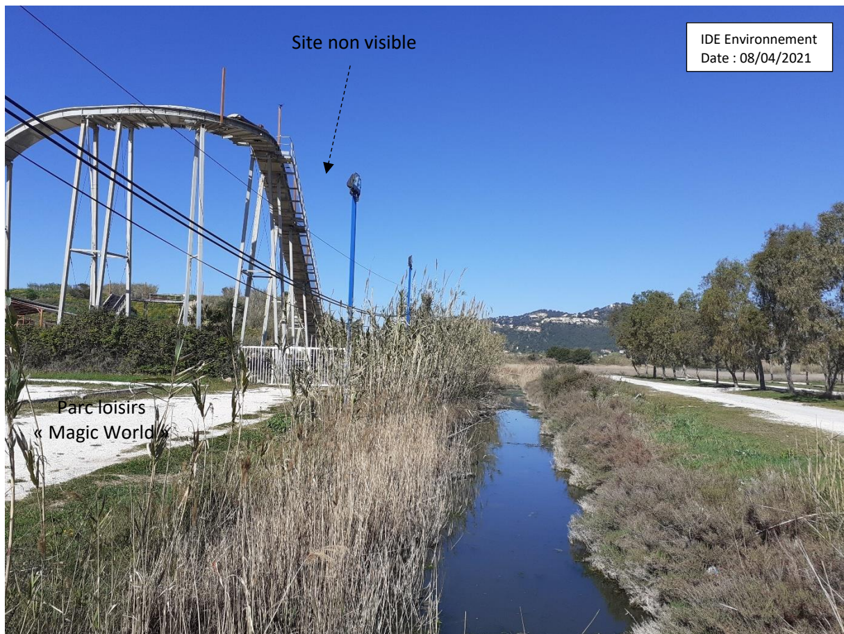
Photo 18 : Vue depuis l'arrière du parc de loisirs
