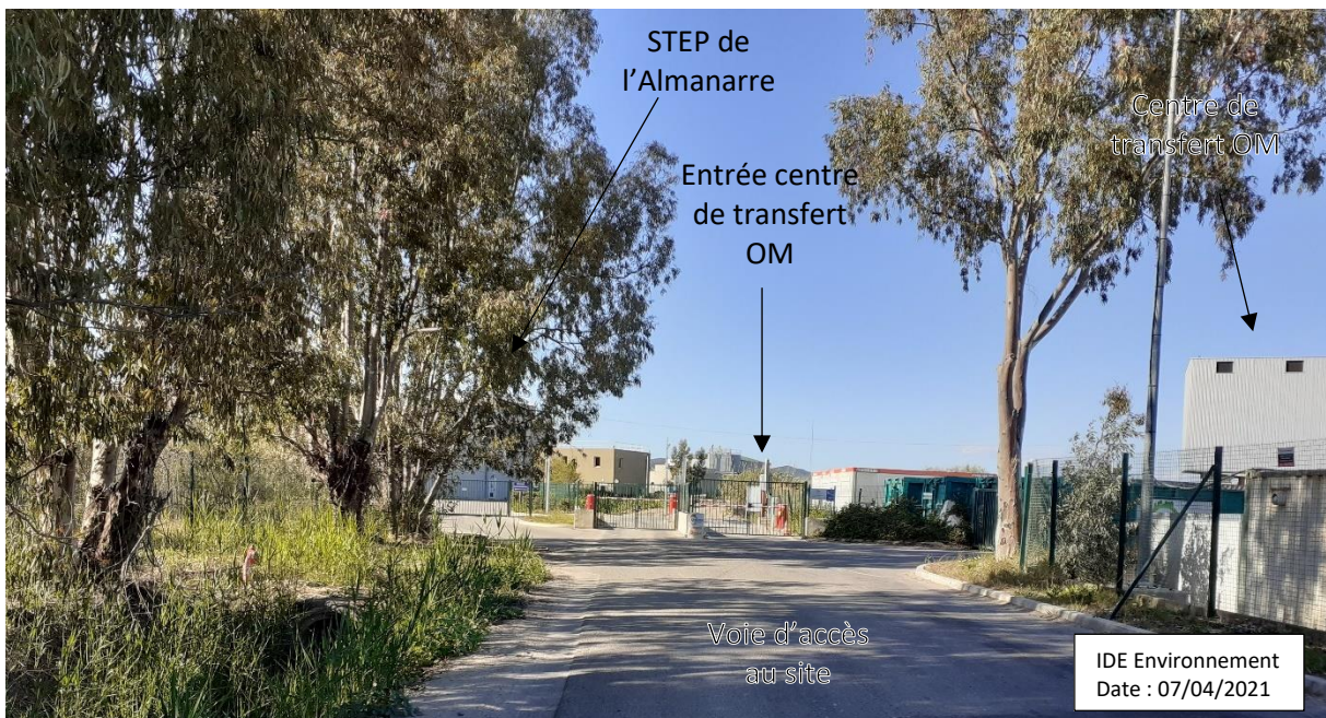
Photo 5 : Vue depuis la voie d'accès du site vers l'entrée de la STEP et du centre de transfert OM
